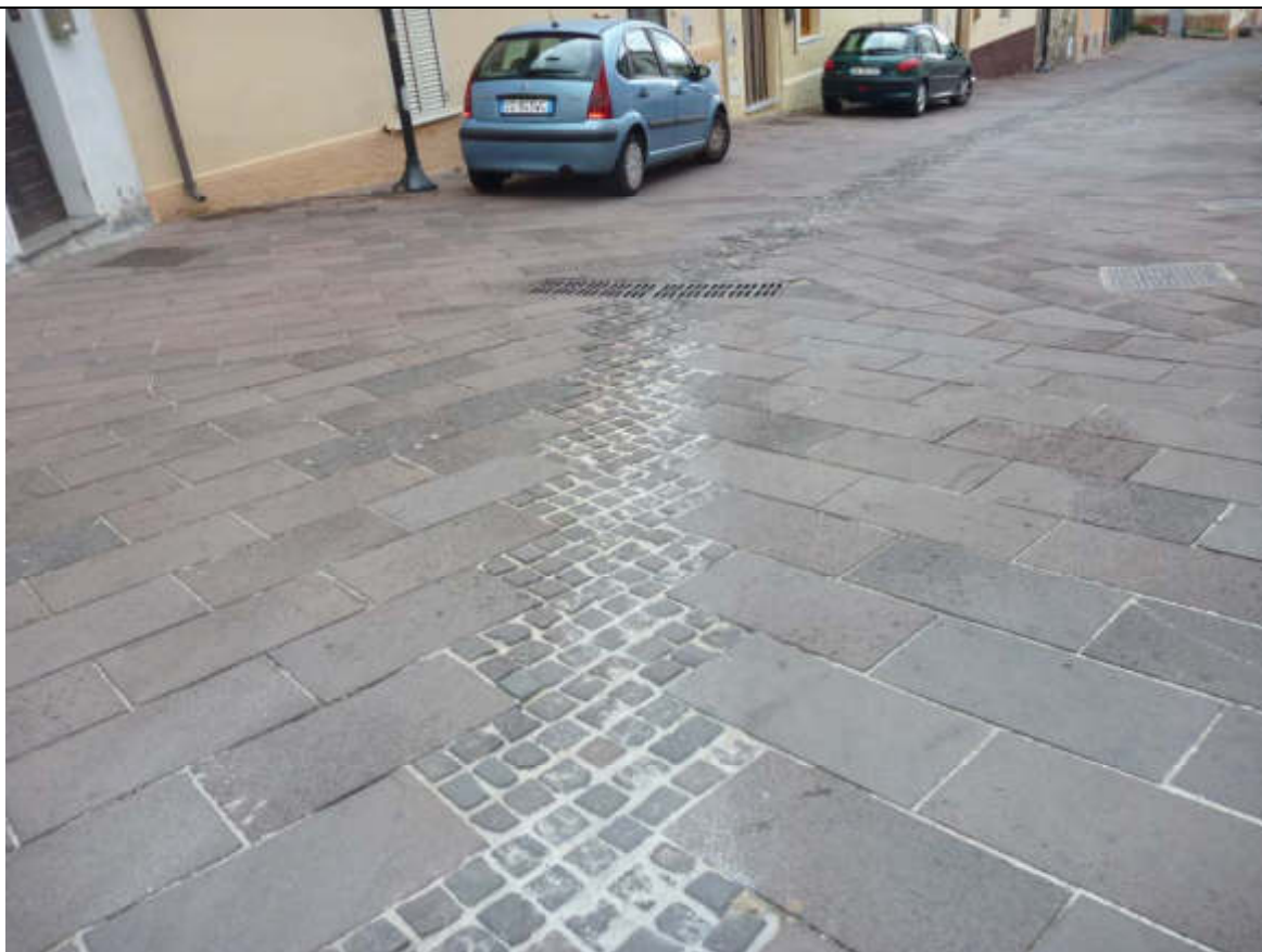
Foto n° 9 – Pavimentazione via Roma con lastre in trachite d’Anglona e canaletta centrale in tozzetti di basalto (2004 – 2006) – Tipologia ritenuta congrua e riproponibile in via Roma alta.
