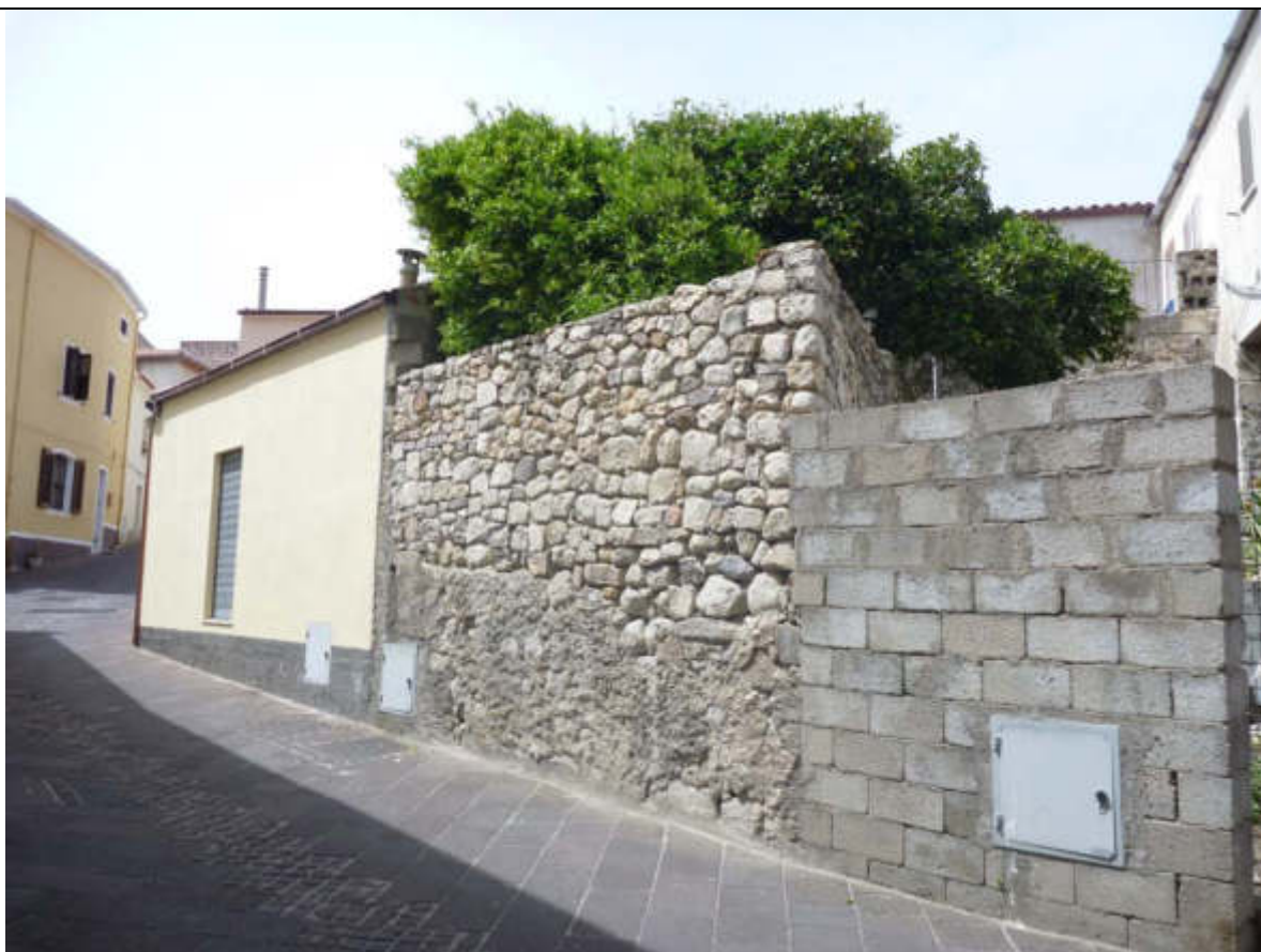
Foto n° 28 – Muro via Vitt. Veneto: si noti muro in blocchetti senza intonaco, muro originario in pietra locale e muro intonacato e tinteggiato. Conservare il muro in pietra e intonacare quello in blocchetti.
