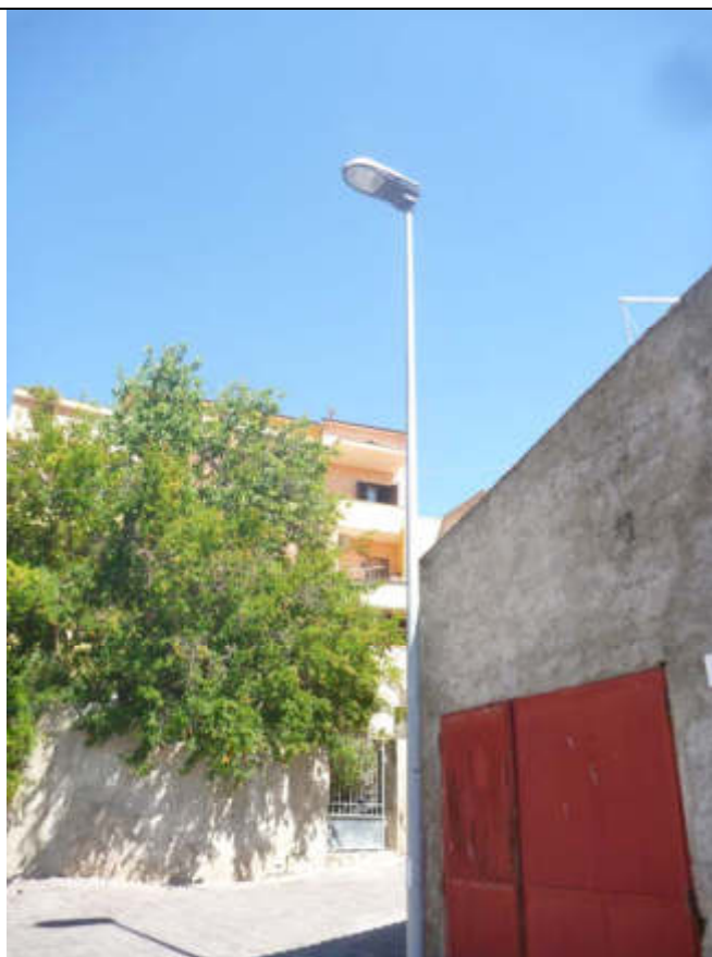
Foto n° 5 – Punto luce a pipa (da sostituire) via Sardegna- Tipologia da rimuovere ( vedi foto n° 3)
