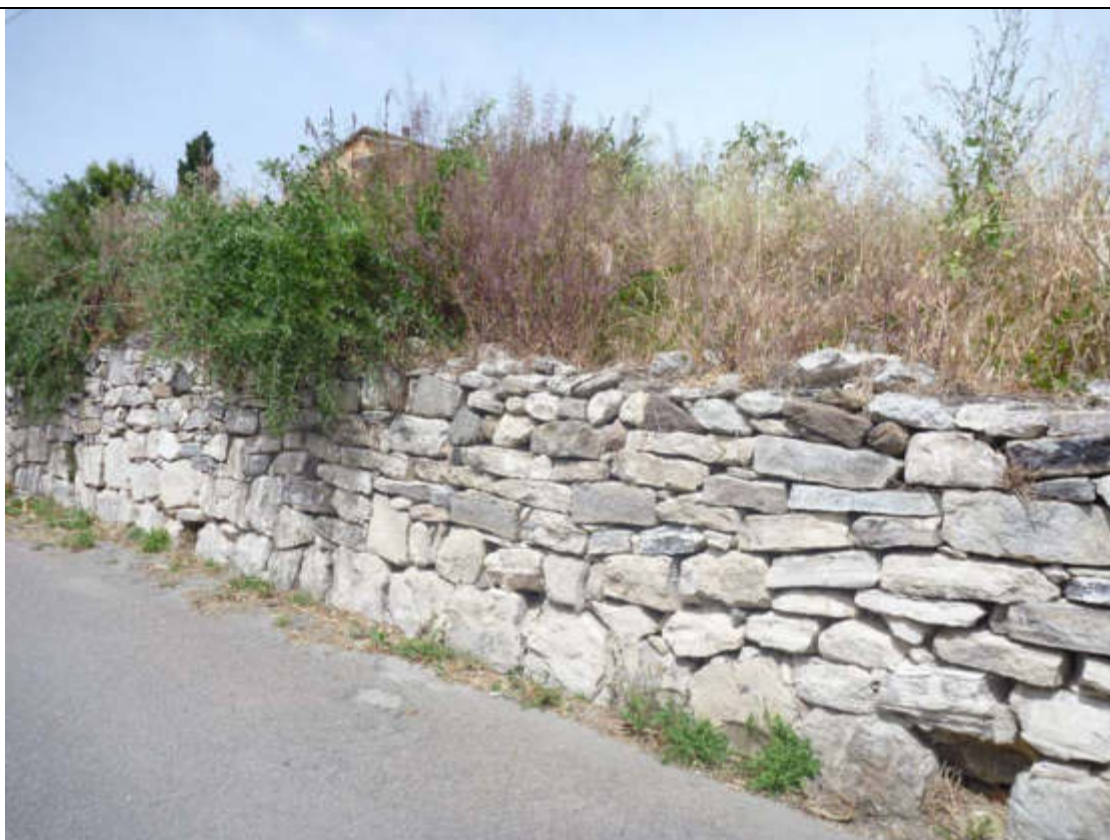
Foto n° 23 – Muro a secco via Roma bassa (uscita Perfugas) con pietre da campo miste di calcare e vulcanite (lato sud) Tipologia da conservare e mantenere.
