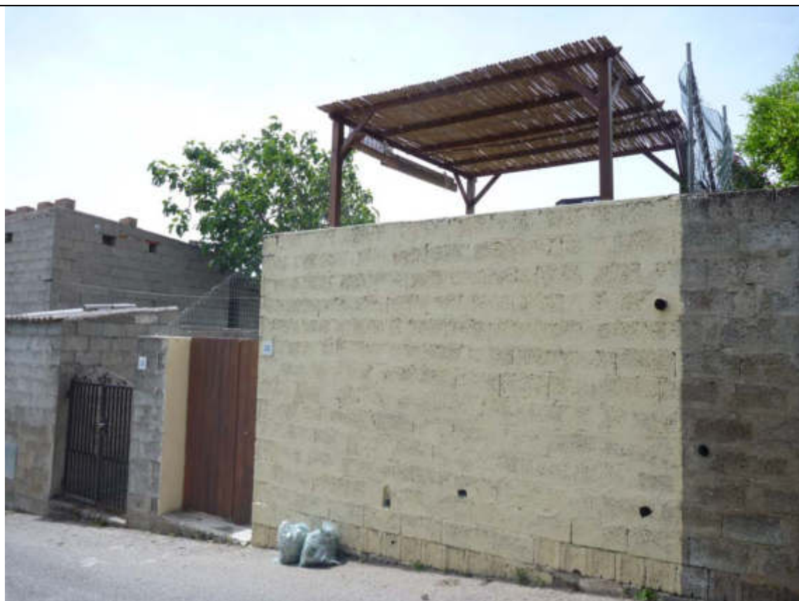
Foto n° 25 – Muro in blocchetti di recinzione (eseguito dal comune per l'apertura di via Anglona) – 1970 da riqualificare con rivestimento in pietra locale e ribassamento altezza.
