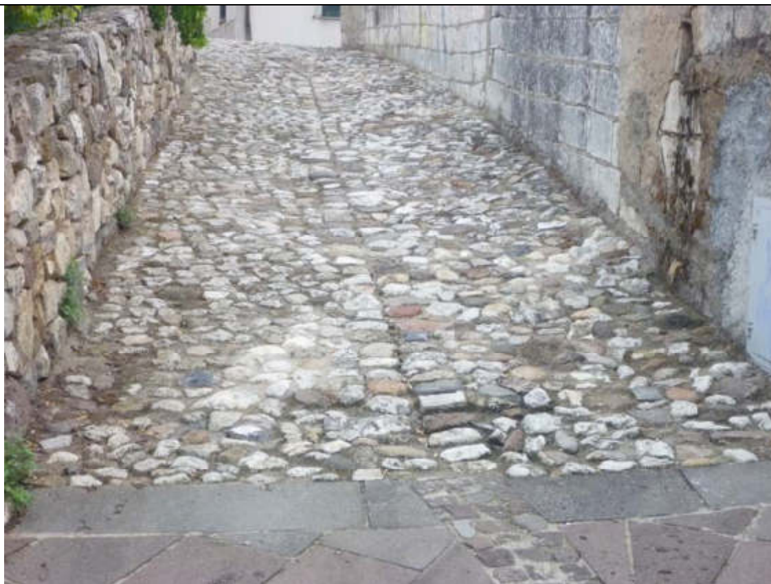
Foto n° 12 – Acciottolato originario (Sas Cortes – Cortes) con muretto a secco in sinistra – Tipologia da conservare e mantenere.
