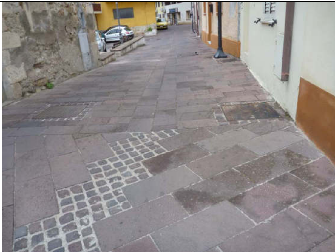
Foto n° 10 – Pavimentazione via Vitt. Veneto (2004 – 2006) – Tipologia ritenuta congrua e riproponibile in Via Roma alta e via Nazionale.
