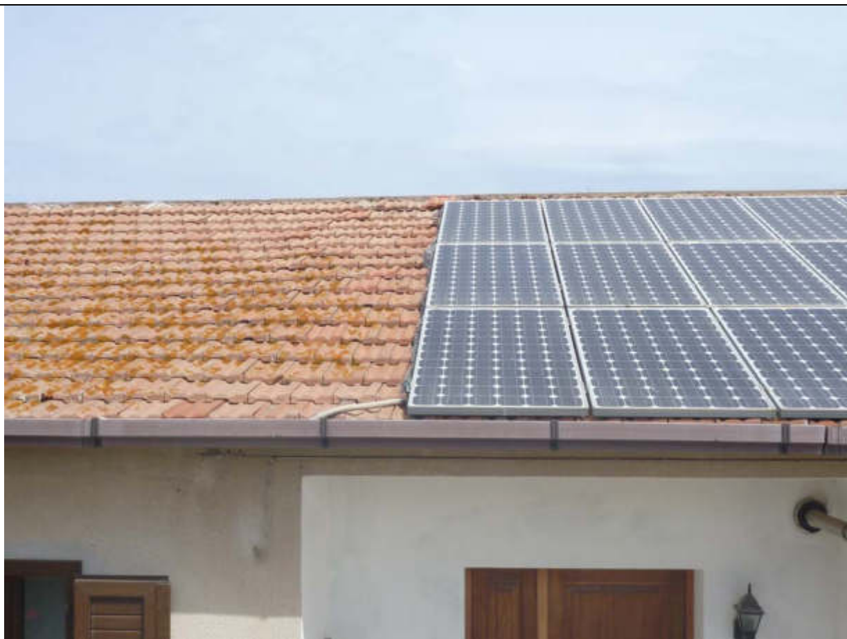
Foto n° 30 – Pannello fotovoltaico su falda con marsigliesi (edificio fuori dal centro storico). Esempio discutibile, forse meglio una diversa distribuzione dei pannelli sulla falda.
