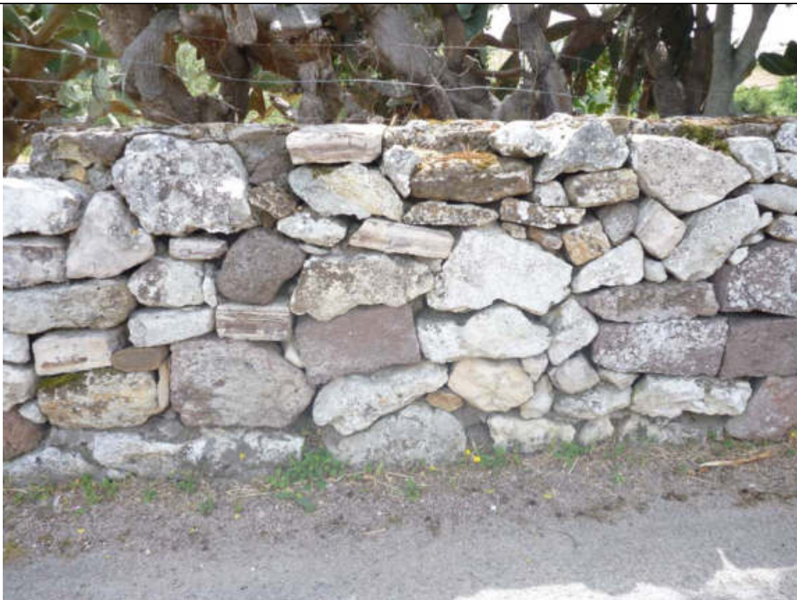
Foto n° 22 – Muro a secco via Roma bassa (uscita Perfugas) con pietre da campo miste di calcare e vulcanite (lato sud) Tipologia da conservare e mantenere.
