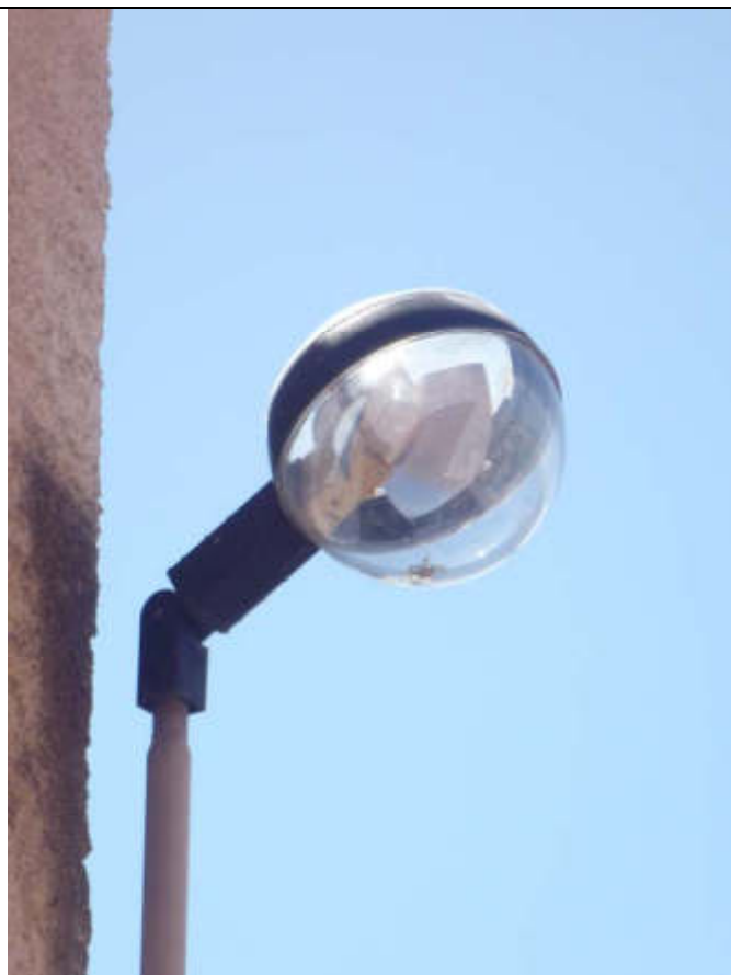
Foto n° 4 – Punto luce a globo (da sostituire) via Sardegna – Tipologia obsoleta da rimuovere e sostituire Con punto luce alla foto n° 3.
