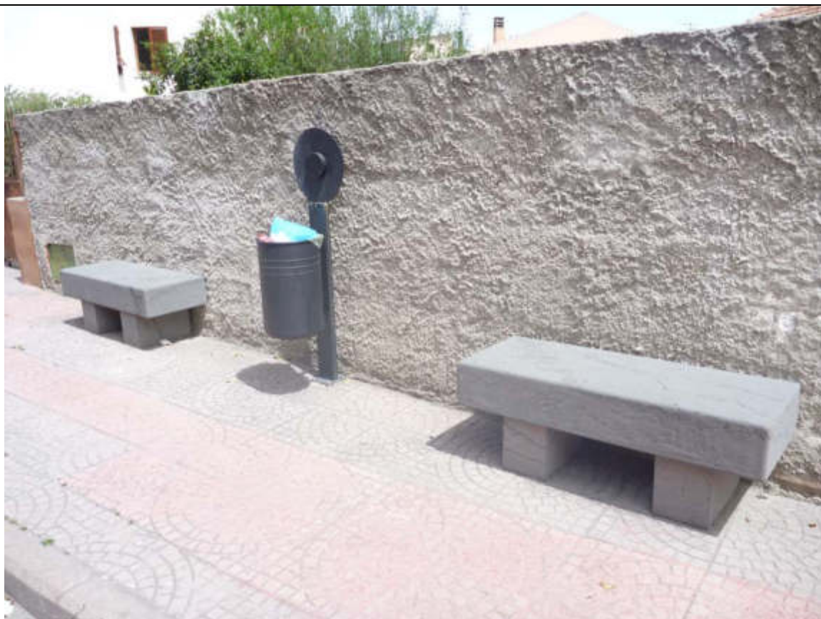
Foto n° 17 – Cestino in acciaio, panche in basalto e pavimento in beole rosse bugnate 30x30 cm – Via Nazionale Fuori dal centro storico.
