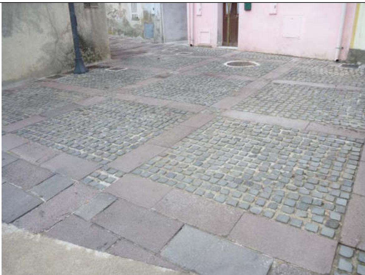
Foto n° 7 – Pavimentazione in tozzetti di basalto e lastre di trachite d’Anglona (2004 – 2006)- Troppo elaborato in considerazione dell’ampiezza dello spazio (via Sebastiano Satta)
