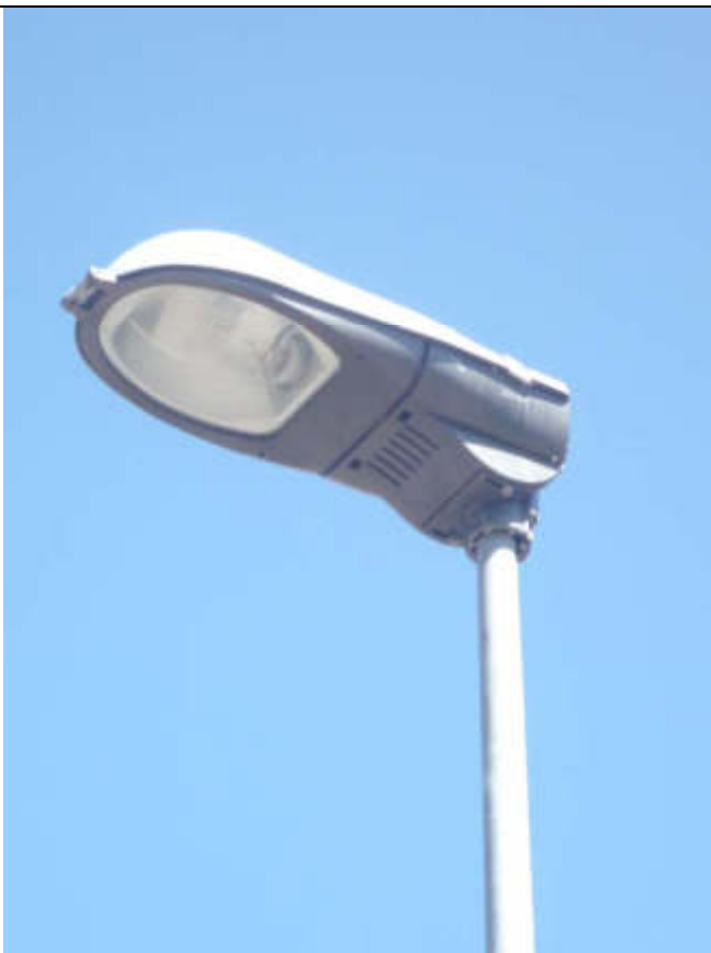
Foto n° 6 – Punto luce a pipa (da sostituire) via Sardegna – Tipologia da rimuovere (vedi foto n° 3)
